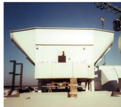
Kreuzstromwäscher Cross-flow scrubber
