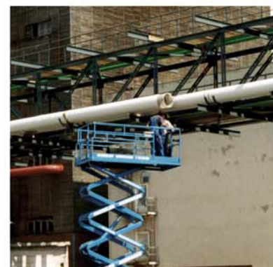
Montage von GFK-Rohren Assembly of FRP-pipelines
